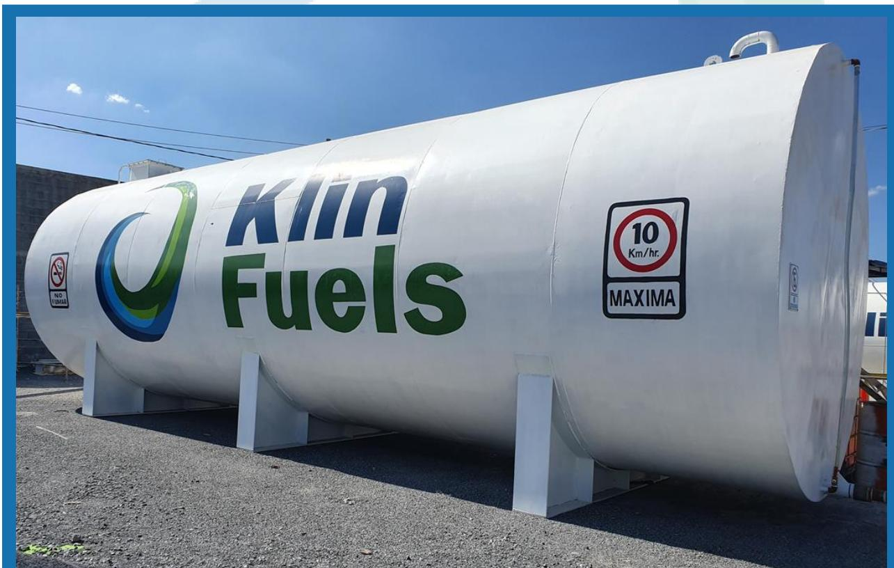
Tanque de acero al carbón con capacidad de 120,000 lts.
